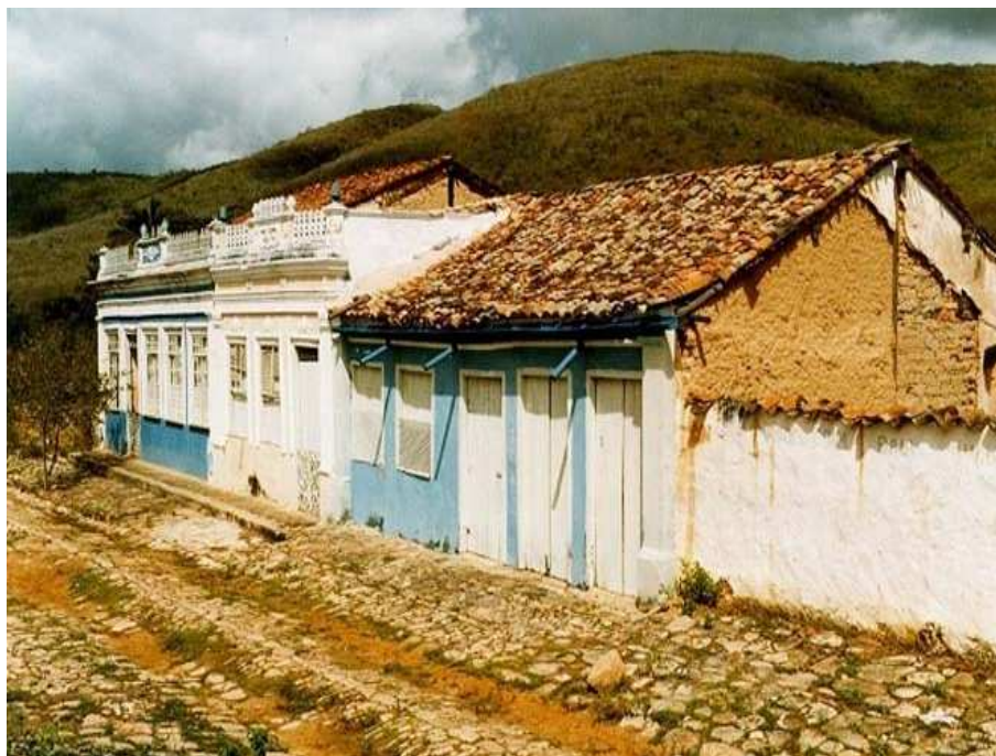
FIGURA 08 - Foto do casario e calçamento de pedra. Foto José Dourado.
