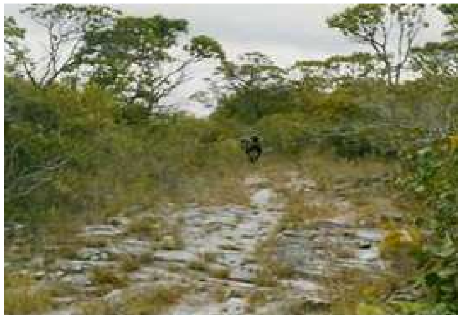
FIGURA 31 - Trecho da estrada que ainda conserva calçamento de pedra. Foto: Luigi Luini
