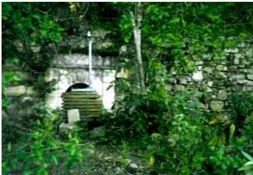
FIGURA 23 - Construção da proteção da nascente d'água do córrego do Rebaixo que deságua no Rio Ventura. Observar detalhe de fechamento de entrada para evitar queda de pequenos animais. Foto: Eliane Sampaio.
