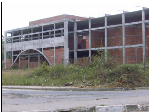
Figura 46 - Obra parada do Centro de Convenções. Itabuna, 2008. Foto: Lize Barroco (20/04/2008).
