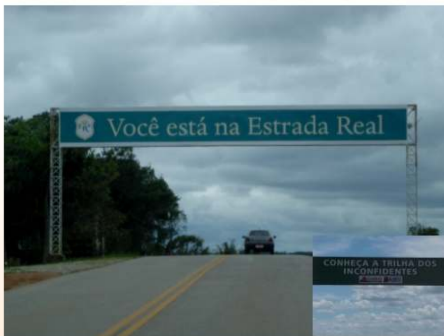
Foto 01 - Portal localizado na MG 383 - trecho entre BR 040 e São João del Rei
