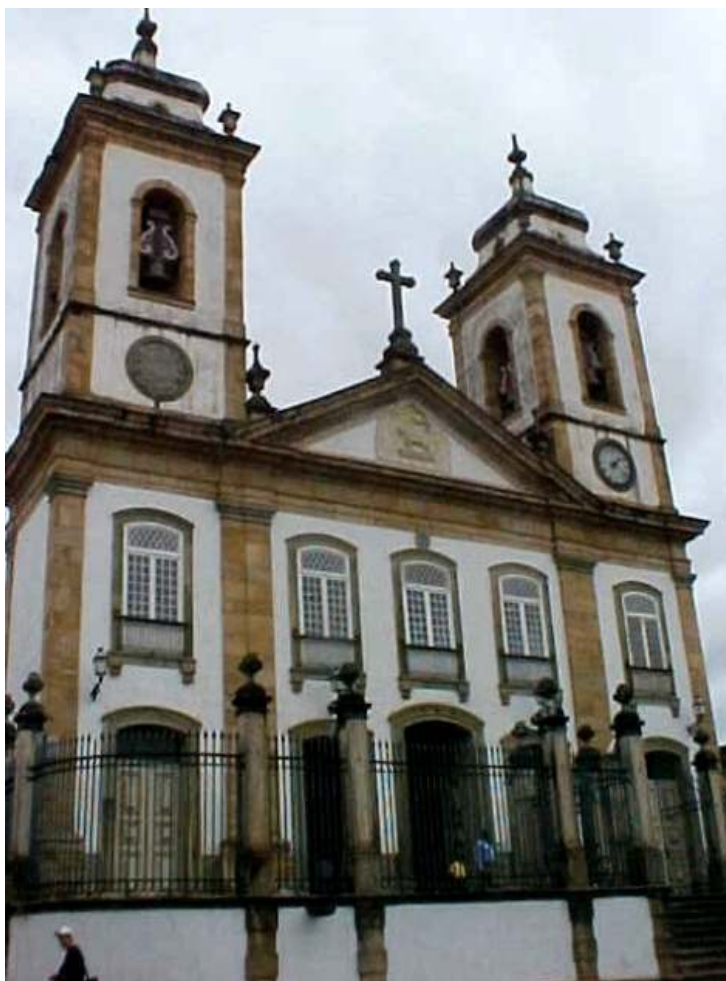
Figura 10 - Igreja Matriz de Nossa Senhora do Pilar.
