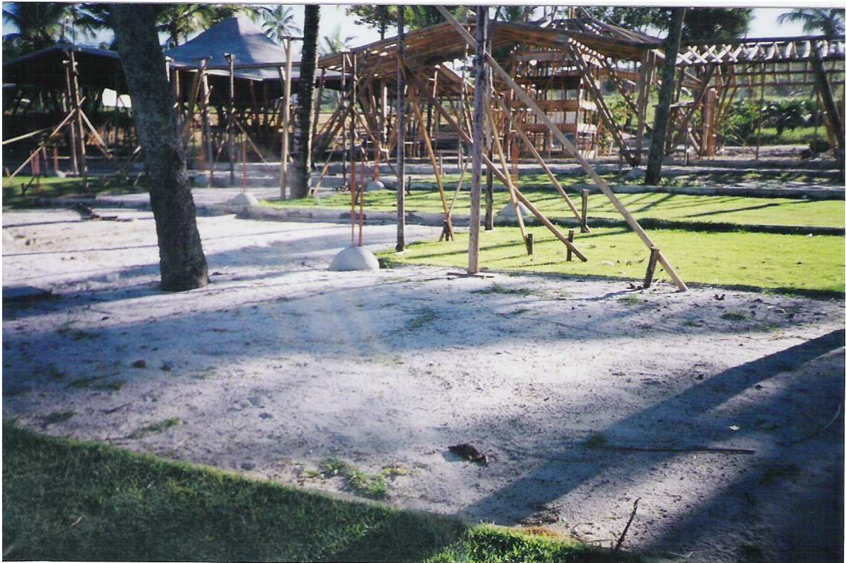
Figura 2 - Construção de um Empreendimento Turístico na Praia de Batuba
