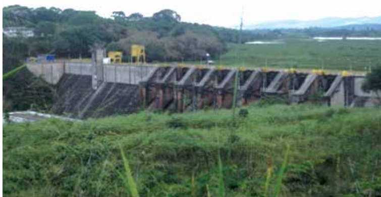
FIGURA 14 - USINA HIDRELÉTRICA DO FUNIL NO RIO DAS CONTAS, UBATÃ, BAHIA
