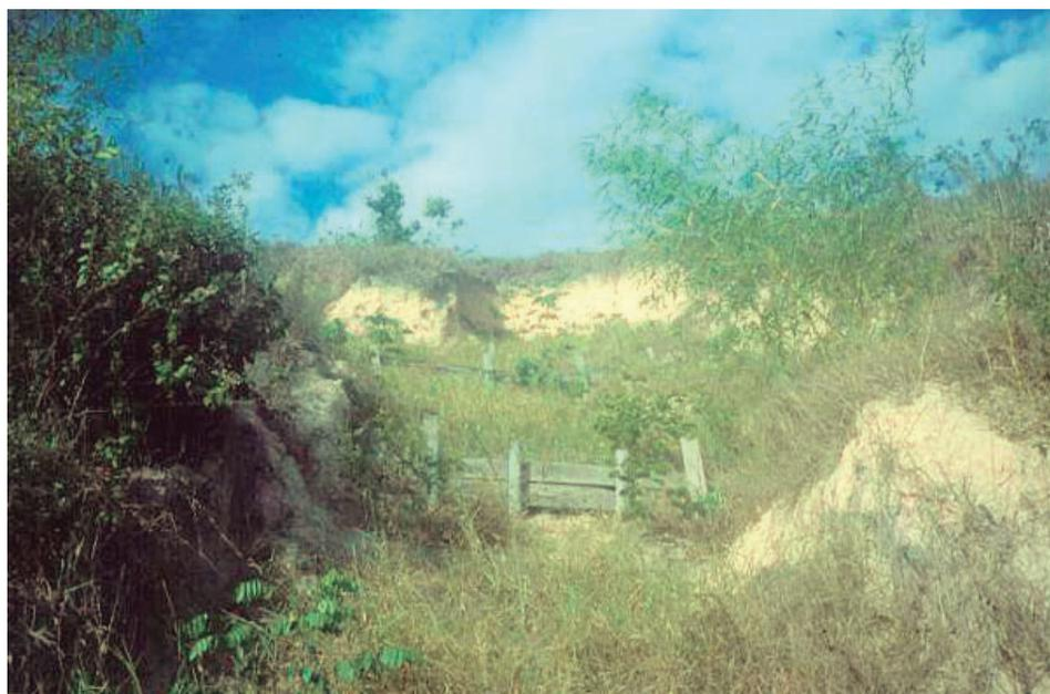
bilizar o canal principal da voçoroca). O uso de sacos de aniagem, paliçadas e outros obstáculos para o aumento do canal principal da voçoroca também são necessários na fase inicial. Somente após a estabilidade física da área, é que partimos para a utilização de métodos biológicos para revegetação e estabilização dos taludes e fundos de voçorocas e sulcos.
