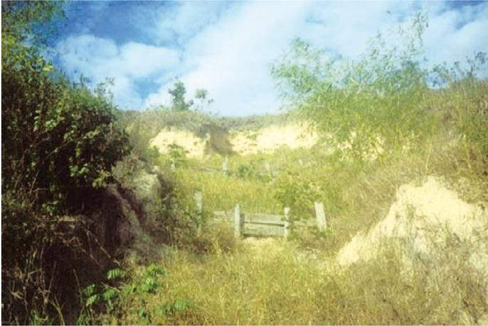
Área degradada de voçoroca em processo de recuperação, através do uso de paliçadas e revegetação com espécies de gramíneas, leguminosas e bambus.
