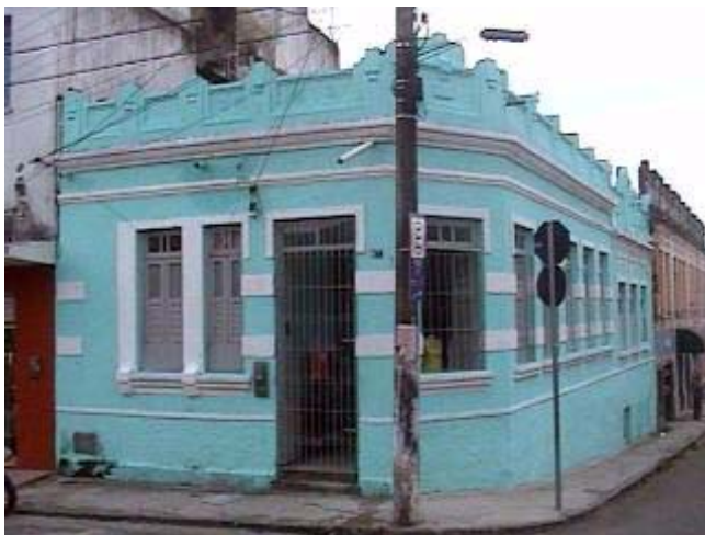
Fig 05: Casa que pertenceu a Ewerton Alves Challoupp. Fonte: Aline de Caldas
