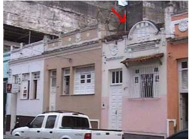
Fig 04: Casas com platibanda em péssimo estado de conservação. Fonte: Aline de Caldas
