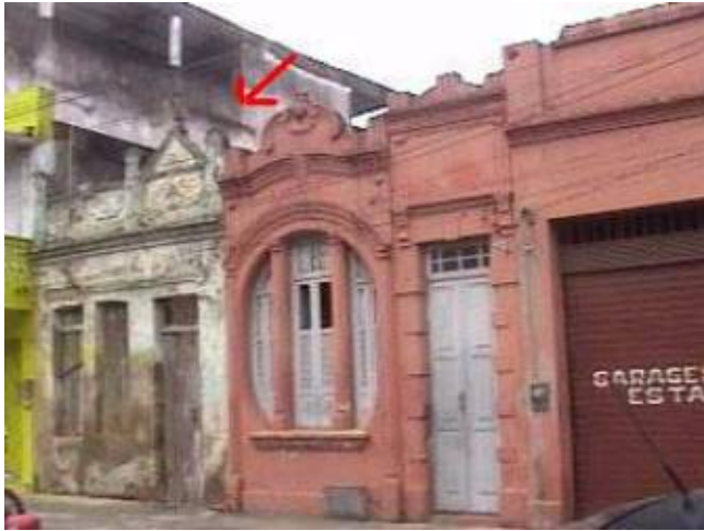
Fi Fig 03: Casas com platibanda em bom estado de conservação. Fonte: Aline de Caldas
