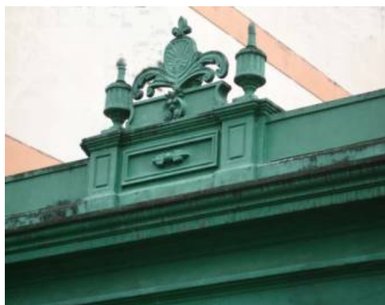
Fig 02: Destaque para a ornamentação da platibanda. Fonte: Aline de Caldas
