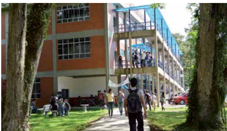
O pavilhão de Exatas possui rampas de acesso
