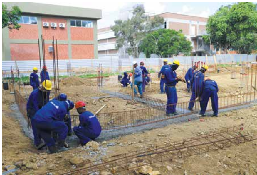
Iniciada construção do prédio do CPBio
