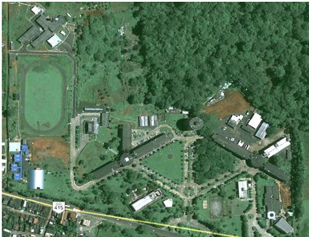
FIGURA 1 – VISTA AÉREA DO CAMPUS
