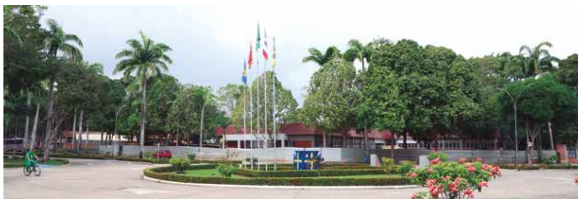
Construção do CIBBiM
